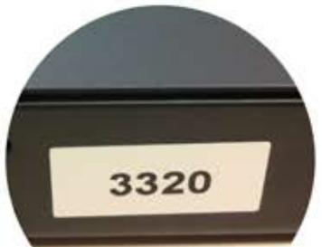
Chaque tiroir dispose d'un numéro unique permettant de relier rapidement le tiroir aux certificats de test concordants. Celui-ci est collé sur l'arrière du tiroir optique.
